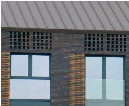
Figuur 2: Close-up van een van de studentenflats uit figuur 1. Op deze foto zijn zes nestgaten zichtbaar. (foto: Jan van Dijk)
